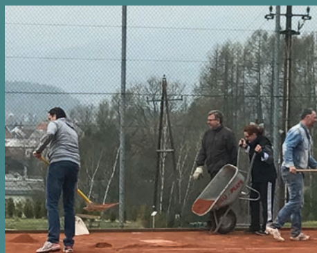
Die jährliche Platzsanierung nach der Winterpause ist im April geplant
