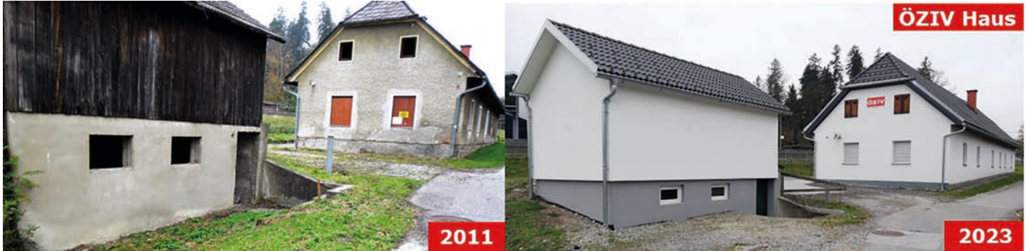
Die Zentrale des österreichischen Zivilinvalidenverbandes in Voitsberg vor und nach der Sanierung
