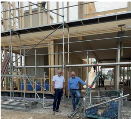
Die Baustelle des neuen Kindergartens am Vorum wird inspiziert
