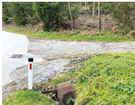
Umkehrplatz Forellenweg wurde erweitert
