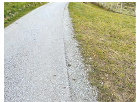
Bankettsanierung am Forellenweg
