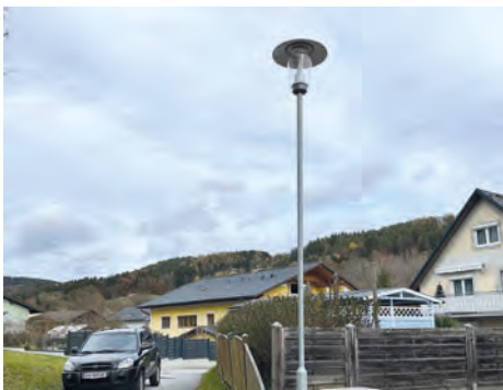
Straßenbeleuchtungserweiterung in Tregist
